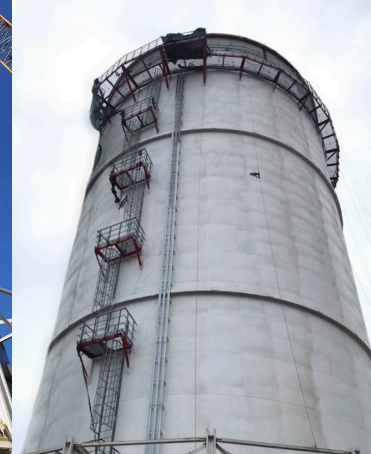
Установка факельная закрытого типа УФБГ-ЗТ после монтажа внутренних слоёв теплоизоляции и стадийной системы горелок
