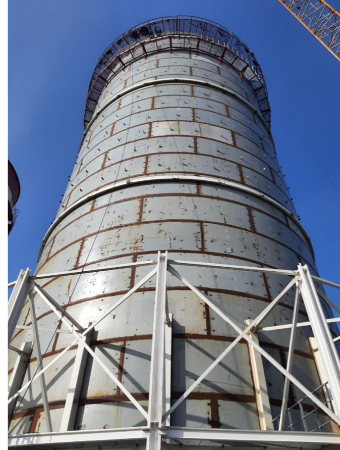
Установка факельная закрытого типа УФБГ-ЗТ после монтажа металлоконструкции
