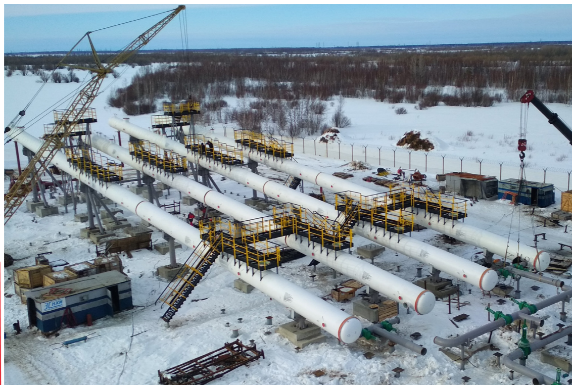
Концевой делитель фаз трубный КДФТ-1400-60-4
