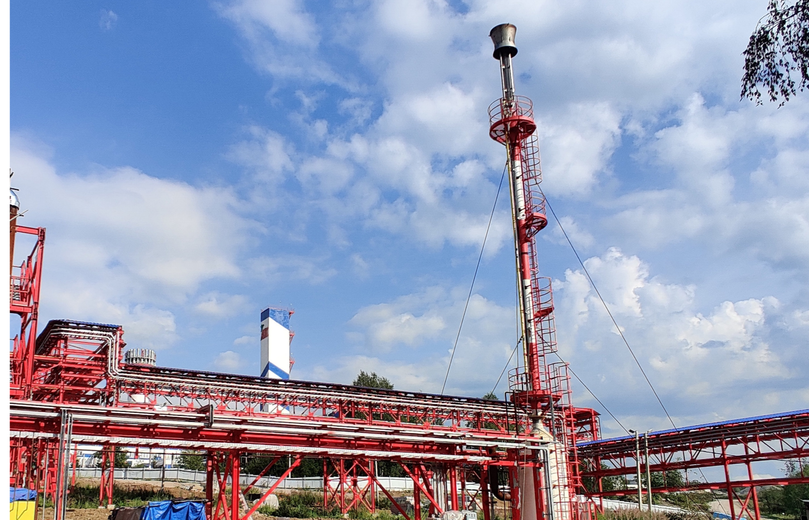
Установка факельная открытого типа УФБГ-250(400)-25
