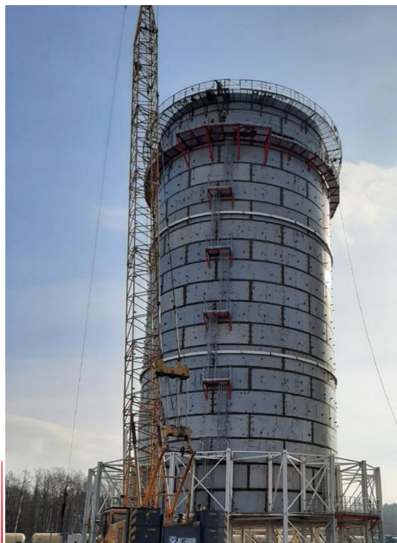
Установка факельная закрытого типа УФБГ-ЗТ в процессе монтажа
