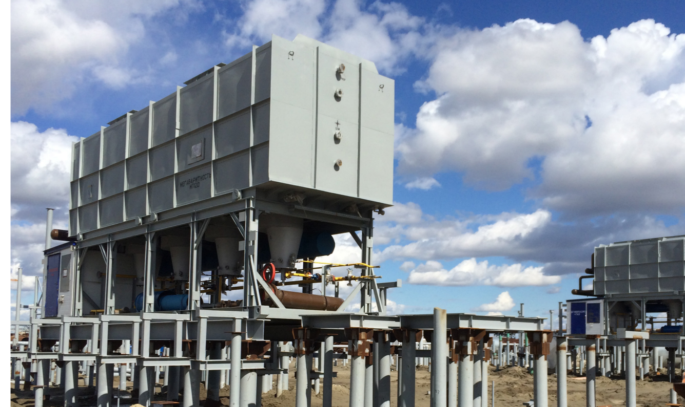
Монтаж печей трубчатых блочных ПТБ-10 на объекте Заказчика
